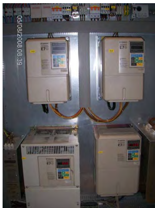
Slika 10. Regulacija broja obrtaja – frekventni regulatori
