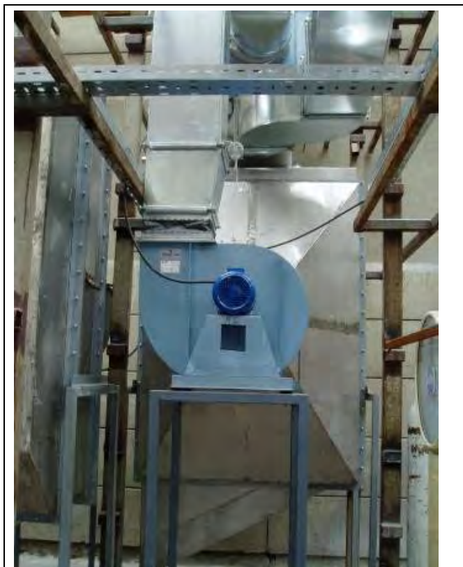
Slika 7. Flilter KF-1A sa 4 kasete K1 za prečišćavanje emisionih gasova odeljenja insekticida
